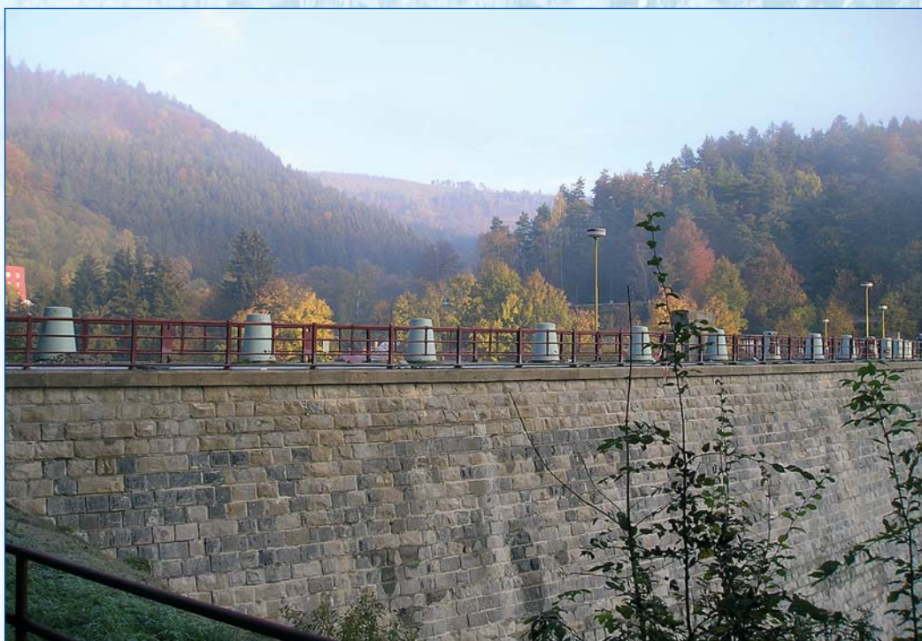
Koruna hráze roku 2004
