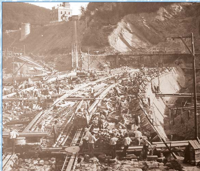
Zdění tělesa hráze v roce 1911
