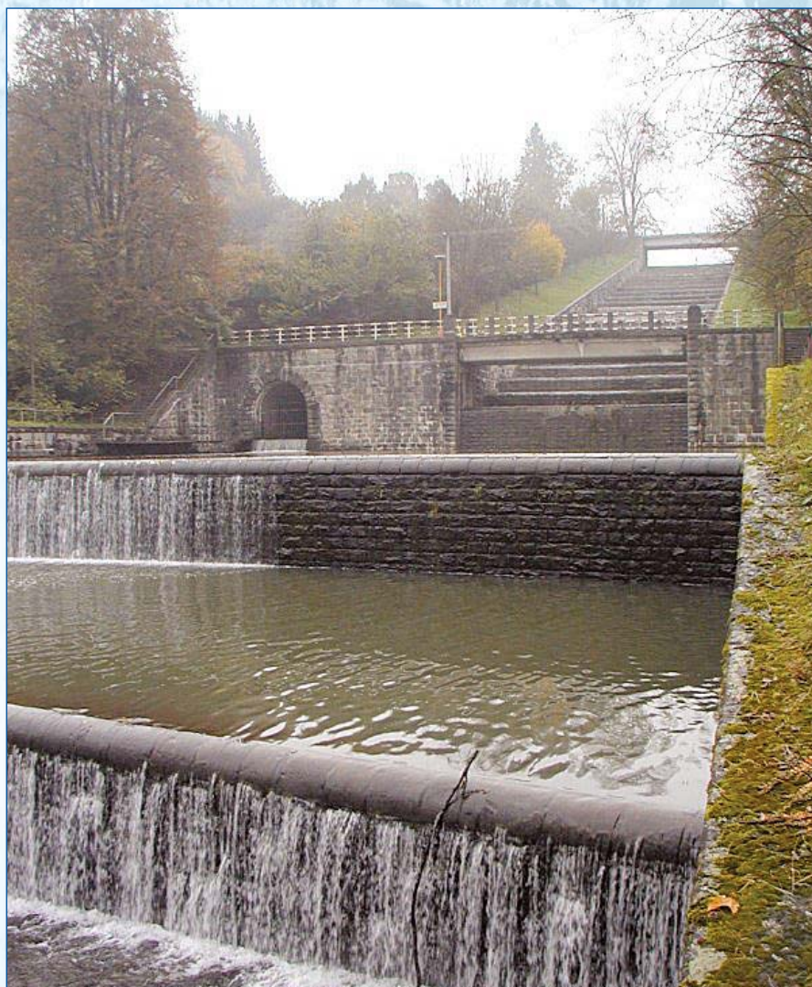
Kaskáda stupňů bezpečnostního přelivu
