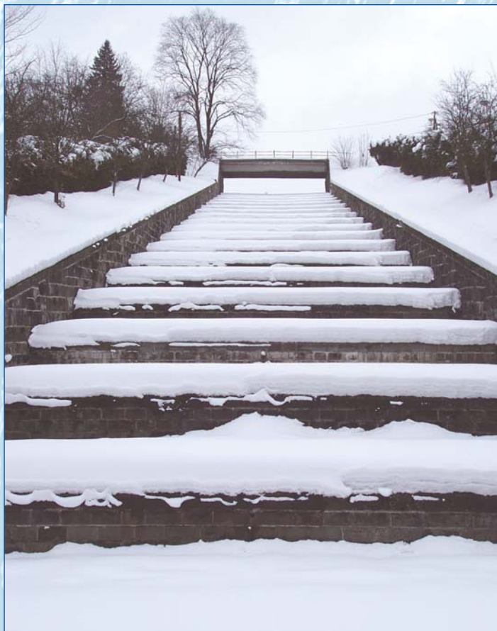
Kaskáda stupňů bezpečnostního přelivu roku 2005
