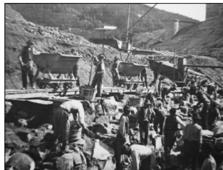
Čilý stavební ruch v prostoru budoucí nádrže
