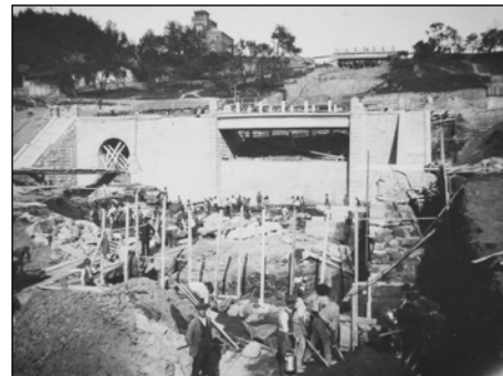
Staveniště přehrad pod hrázi - budování kaskád a vypouštěcího tunelu
