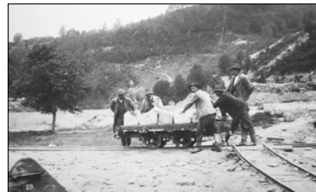
Doprava materiálu na staveniště - v době výstavby přehrad byla zřízena úzkorozchodná trať z vlakové stanice Roušťka (dnes zastávka Bystřička).
